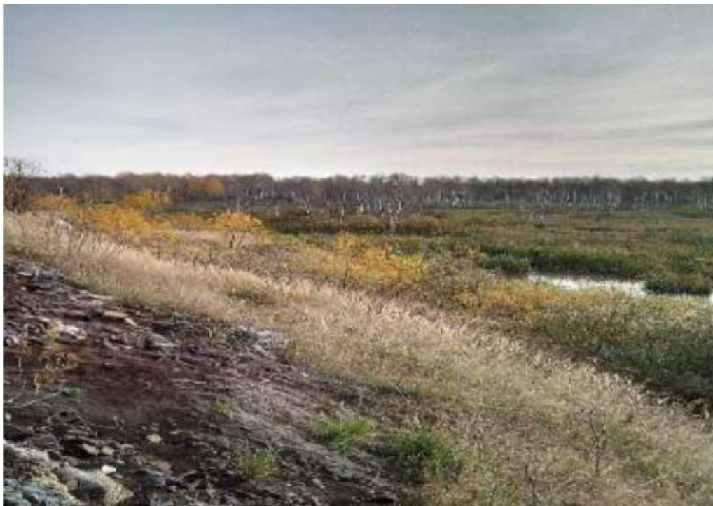
Рисунок 2 – Общий вид полигона промышленных отходов
